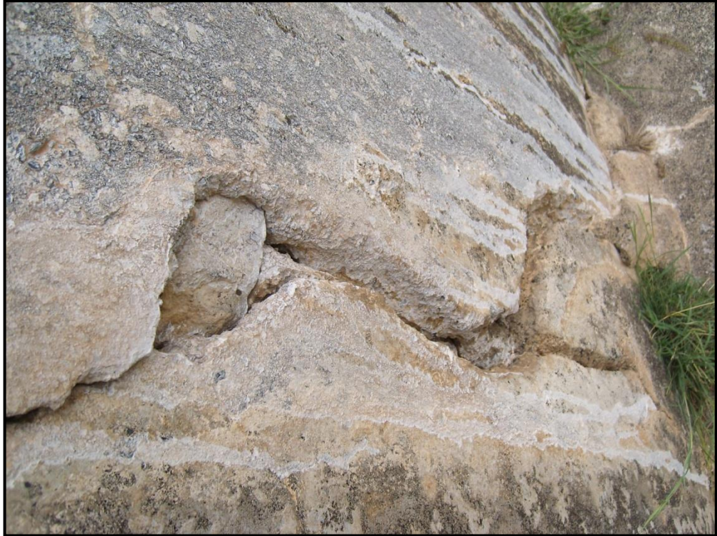
التشققات التي تظهر على جسم قبة الضريح
