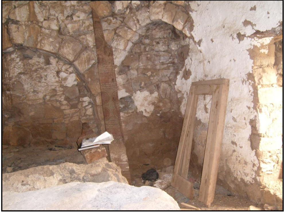
تقدم أجزاء القبة على الواجهة الشمالية والجنوبية التي تطل على فناء قاعة المعالمة ( الكتاب ) وحجرة السكن لحنايا الركنية لقبة الضريح
